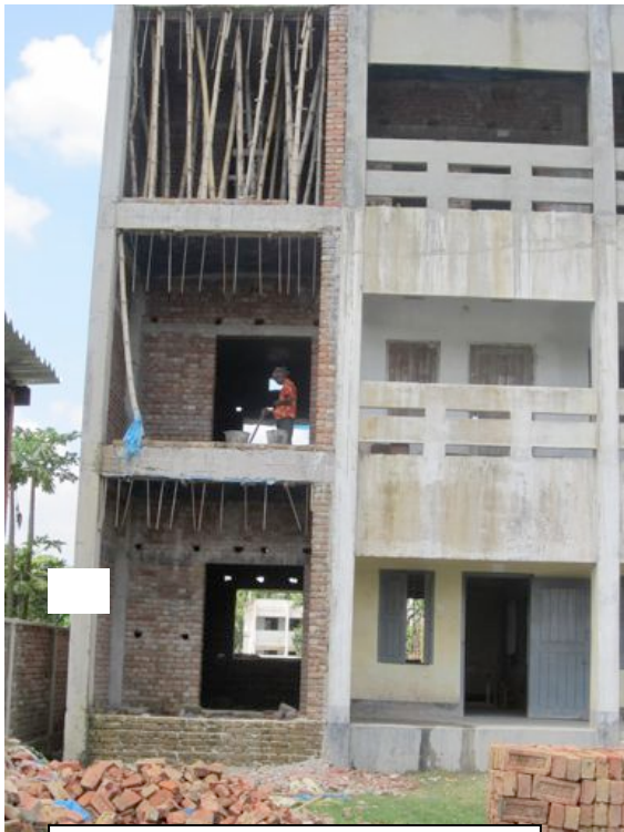
三階までの工事
